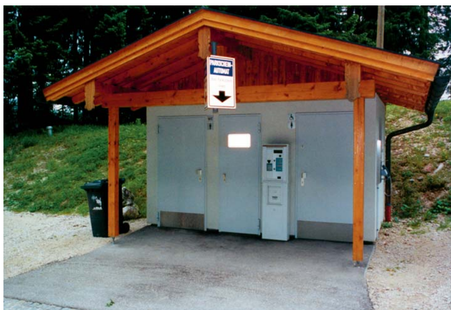
Rollstuhlgeeignete Toilette am Göllhäusl/Hinterbrand
